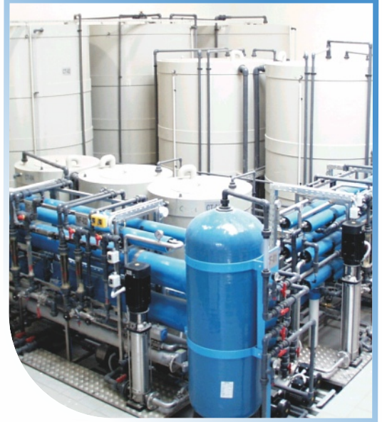
Čistenie odpadovej vody z výroby súčiastok letadiel a recyklácia do technológie. GE Aviation Hungary Kft. / Maďarsko 100 m 3 /deň
