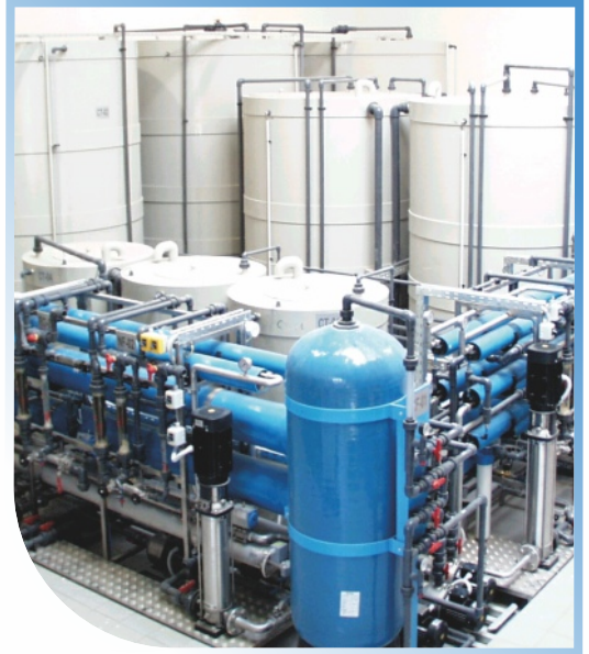
Purificarea și recircularea apelor reziduale provenite din producția de piese de aeronave cu tehnologie ZLD. GE Aviation Hungary Ltd. / Ungaria 100 m 3 /zi
