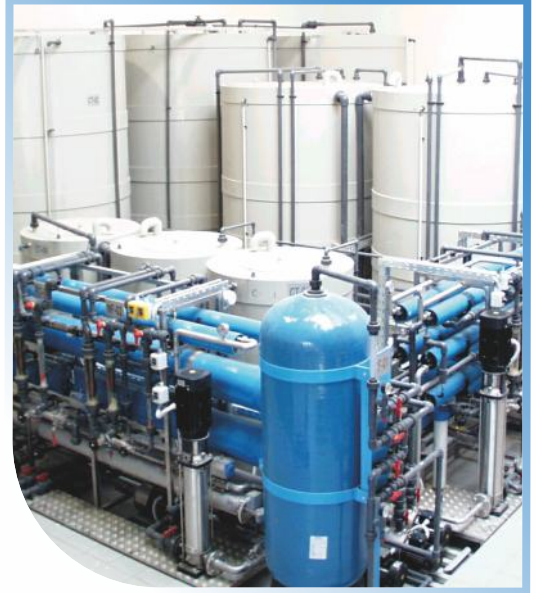
Tratamiento de las aguas residuales generadas en la producción de piezas de aviones y su reciclaje al proceso. GE Aviation Hungary Kft. / Hungría 100 m 3 /día
